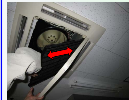
③フィルターを止めているツメからフィルターを外し出す
