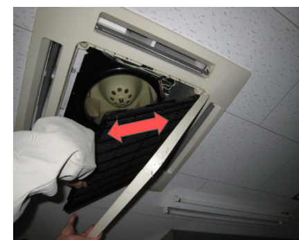
③ フィルターを止めているツメからフィルターを外し取出す
