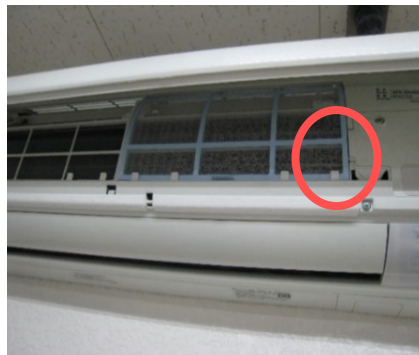
②フィルターを止めている ツメを外す
