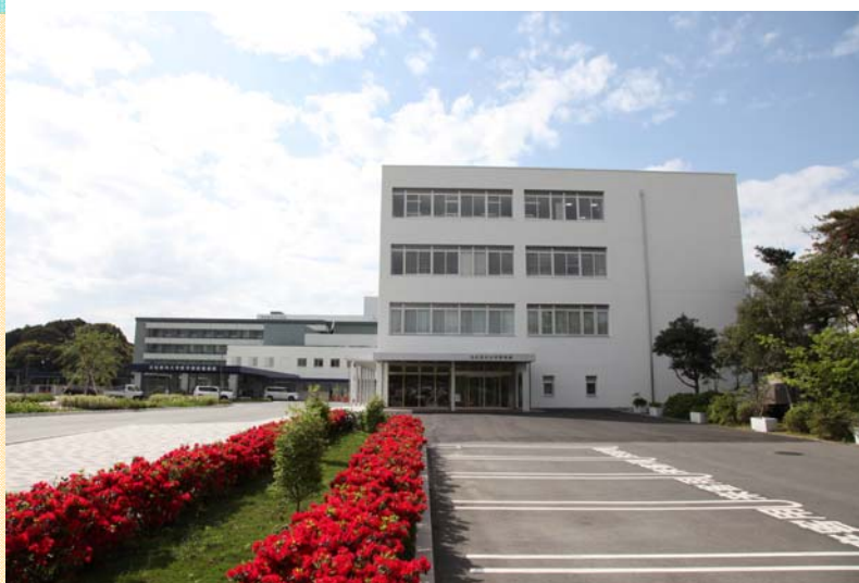
全面改修を実施し、利便性と執務環境の向上した管理棟 (平成27年4月撮影)
