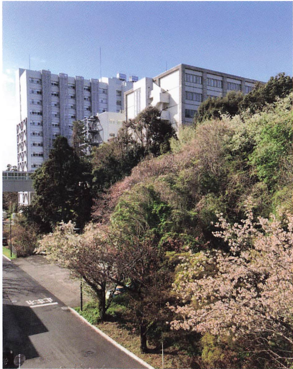
看護学科棟（手前）と基礎臨床研究棟（後方）
