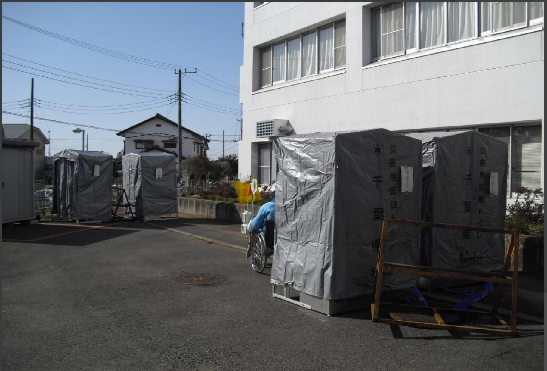
仮設トイレ設置
