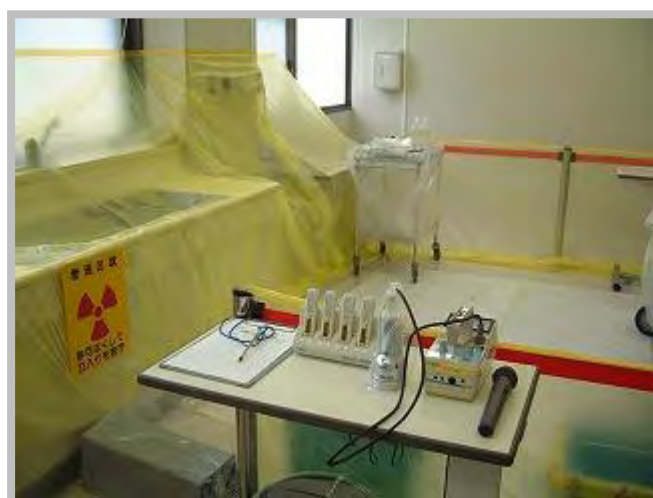
図 3-3. 処置室室内の養生
