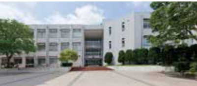
講義実習棟(改修前)
