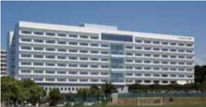
医学部附属病院新病棟(2009年完成)
