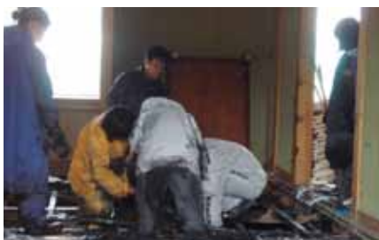
2011.5 石巻津波の被害を受けた民家の泥出し作業
