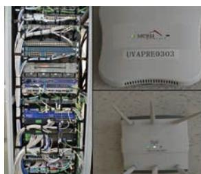
写真3 大学のネットワーク基幹システムと拡充設置中の無線アクセスポイント
