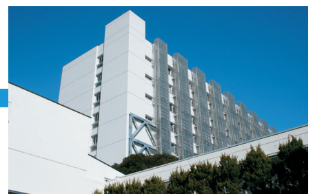
基礎臨床研究棟耐震改修事業(第II期)
