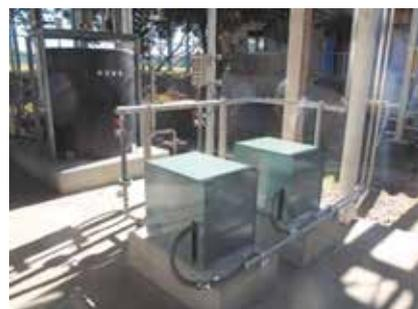
B系廃水貯留槽の空気吹込み量を増加した工事
