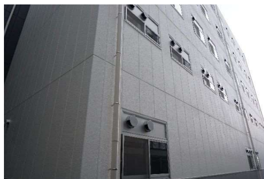
医工連携拠点棟 南面
