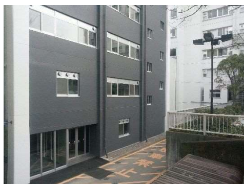
医工連携拠点棟 北西面
