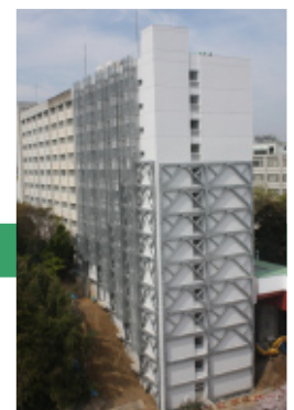
基礎臨床研究棟耐震改修事業(第1期)
